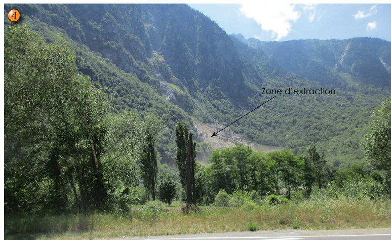
Depuis la RD1006, au nord/nord-est du site Hauteur du point de vue : 479 m NGF Distance du site : 360 m
